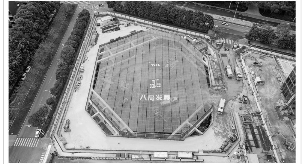
近日在TCL先进半导体显示产业总部项目上拍摄的智能“天幕”(无人机照片)。在位于深圳湾超级总部基地的TCL先进半导体显示产业总部项目基坑,既能降低扬尘和噪声污染,又可遮阴的大跨度防尘天幕系统为项目撑起了一把“智能伞”。
