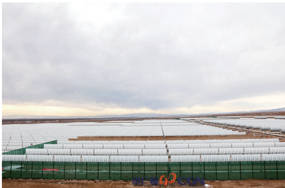
中广核项目现场。
