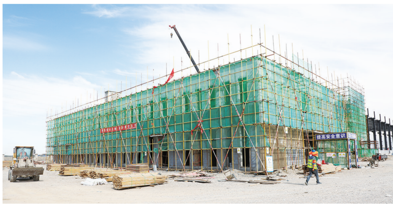
图为中车海西州新能源装备制造零碳产业园项目施工现场。
