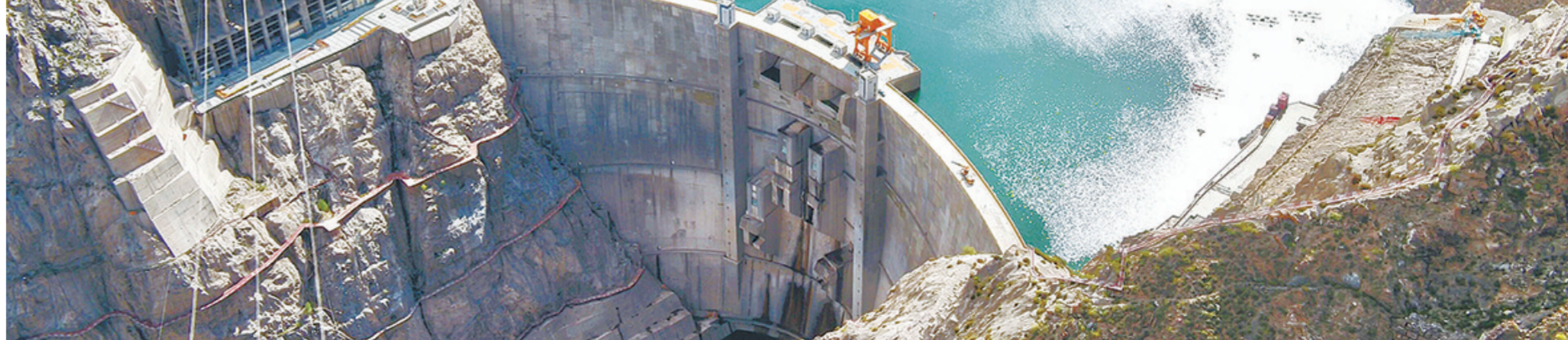
拉西瓦水电站远景。
