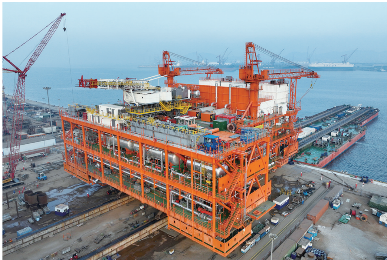
10月25日，埋北油田中心平台正在进行装船作业(无人机照片)。
