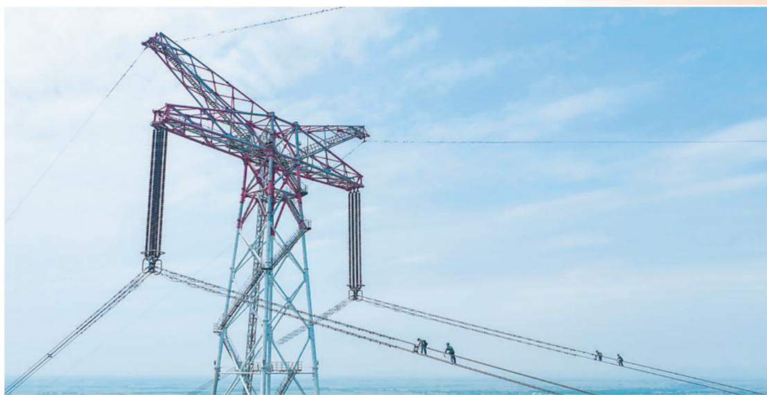
五月一日，安徽省安庆市望江县，工人在两百多米的高空检修特高压跨江线路。
