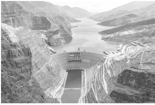
这是2023年9月18日拍摄的白鹤滩水电站（无人机照片）。新华社记者 陈欣波 摄
