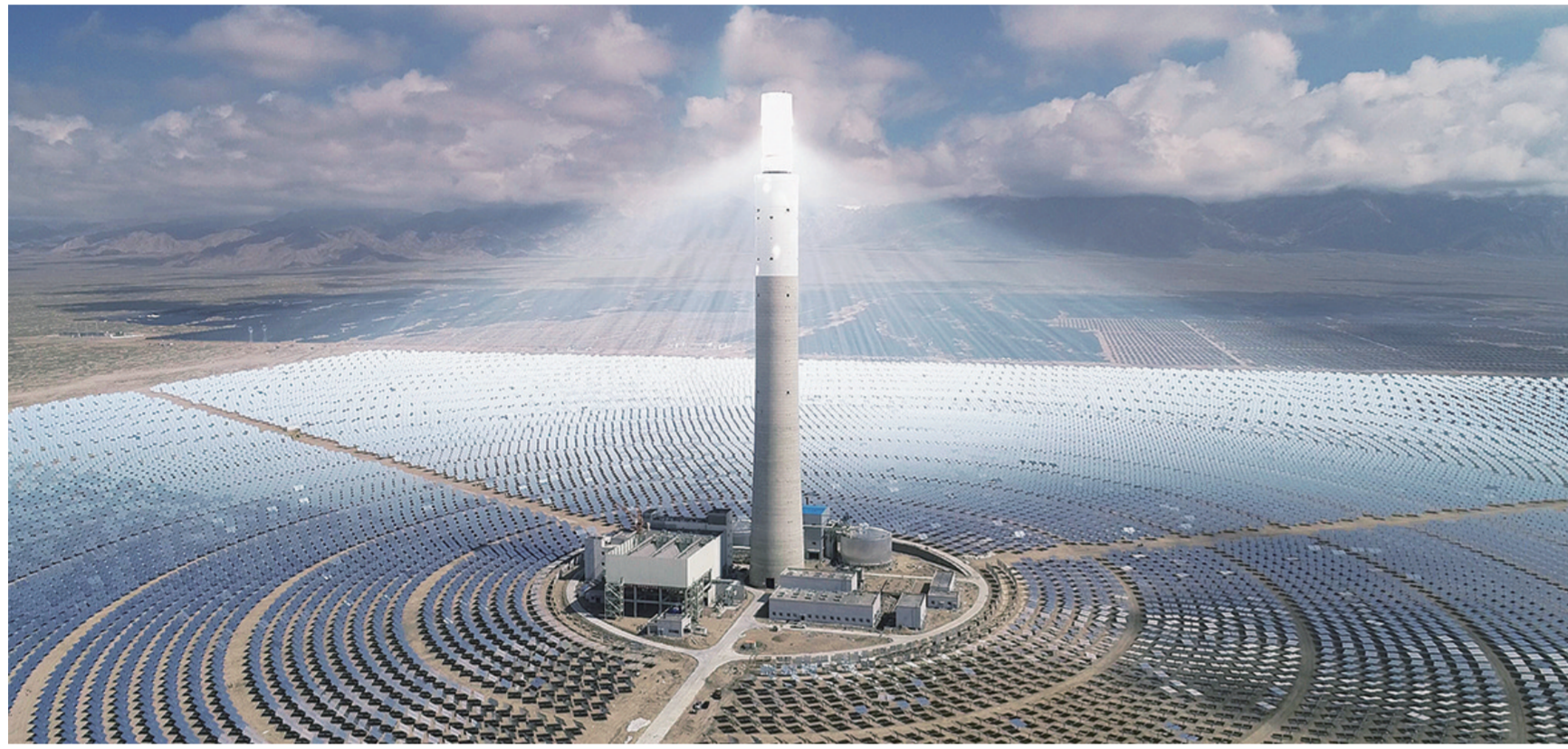
青海中控50MW塔式熔盐储能光热电站俯瞰图。
