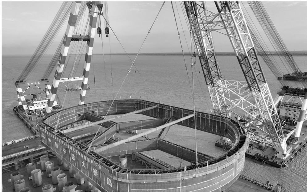
8月20日在江苏省启东市拍摄的崇启公铁长江大桥4号主墩首节钢围堰安装现场(无人机照片)。
