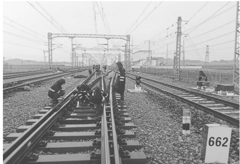
探测着钢轨内部的细微病害，不放过任何一个可能预示钢轨“病情”的异常信号。
