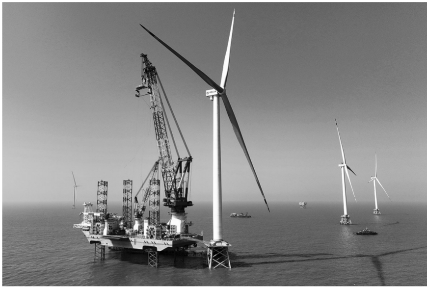
1月13日在闽南海域拍摄的“大桥海风”号2000吨自升式海上风电安装平台和吊装完成的20兆瓦海上风电机组(无人机照片)。 1月13日,由三峡集团与金风科技联合设计建造和示范应用的20兆瓦海上风电机组在福建闽南海域完成吊装。该机组的成功吊装,是我国海上风电大容量机型应用的又一重要突破。 新华社记者 林善传 摄
