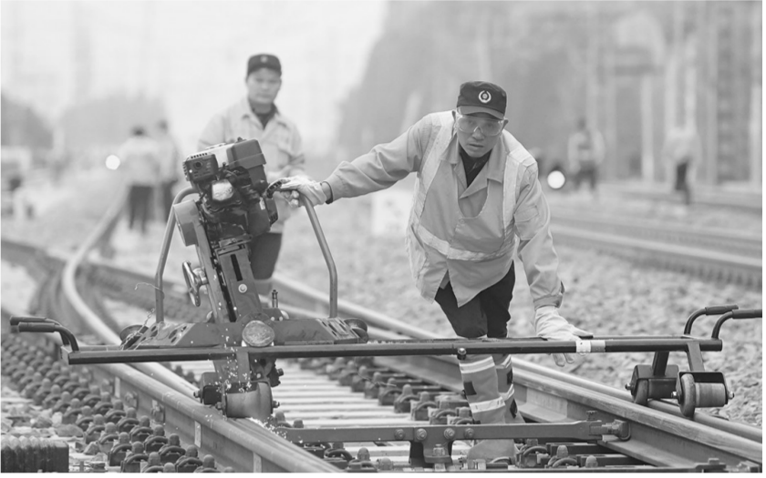
1月29日，中国铁路南宁局集团有限公司百色工务段八渡线路车间工人在进行钢轨打磨作业。
